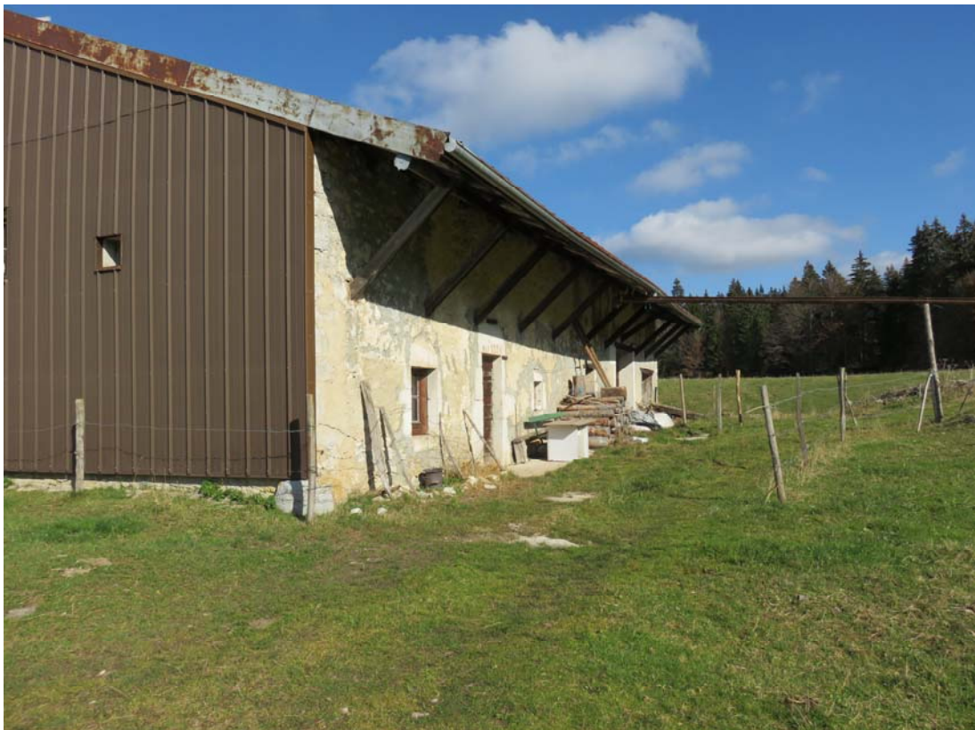
L'avant-toit, particulièrement important, est soutenu par des poutres de soutènement obliques.
